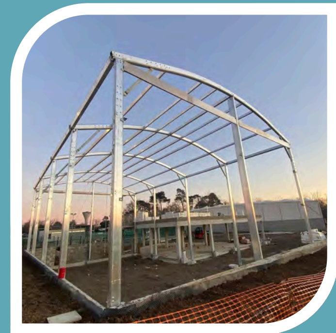
Construction du centre de padel à Camblanes-et-Meynac (33)
