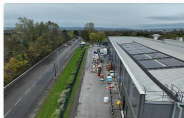
Panneaux photovoltaïques sur l'actif situé à Glasgow.
